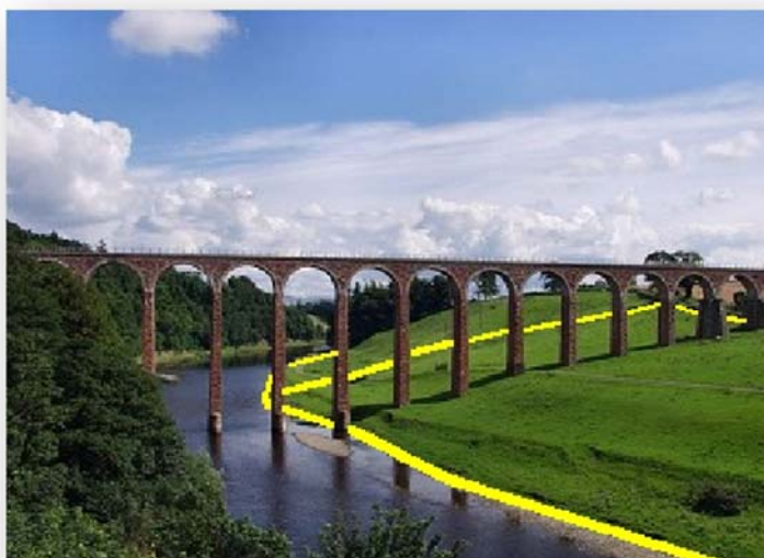
Figura 35 - Prédio delimitado sob obra de arte
