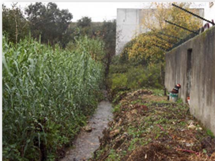
Figura 17 - Canal ou vala
