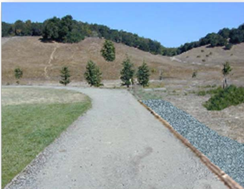
Figura 7 - Via rodoviária em zona plana
