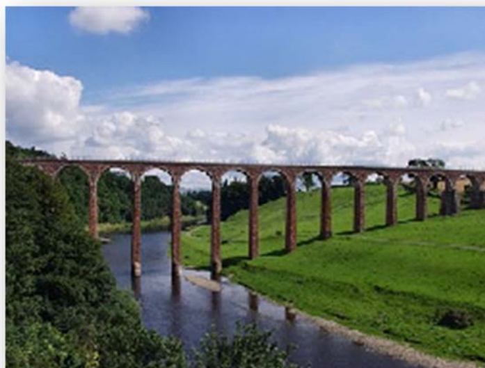
Figura 34 - Obra de arte
