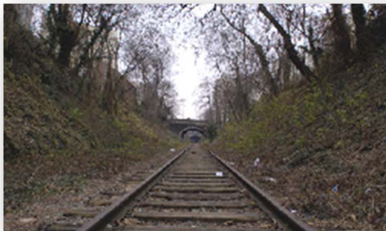
Figura 13 - Via ferroviária em zona com declive
