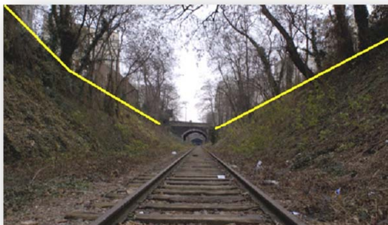
Figura 14 - Prédios delimitados juntos a via ferroviária em zona com declive
