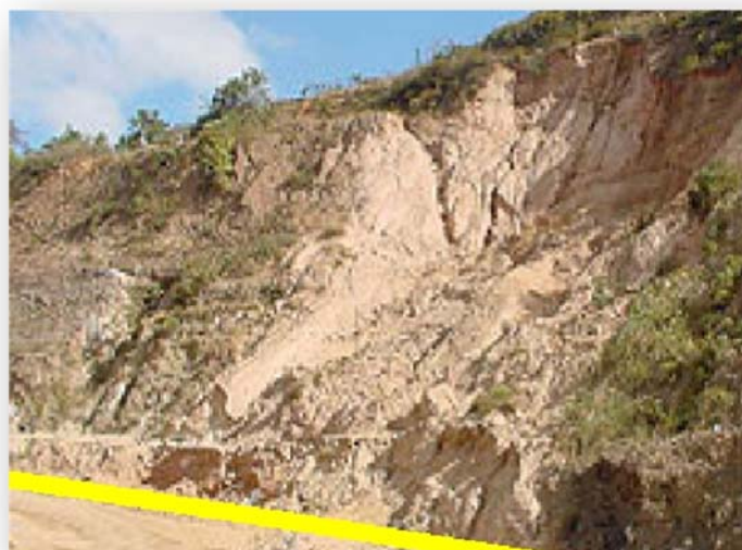
Figura 2 - Delimitação de prédio junto a talude natural
