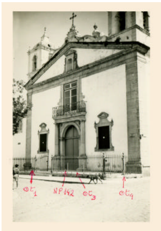
Marcas NP 142 e testemunhas t1, t2, t3 e t4. A NP 142 está chumbada na soleira da porta da Igreja de Santa Maria, em Lagos, junto da ombreira do lado do Evangelho.
