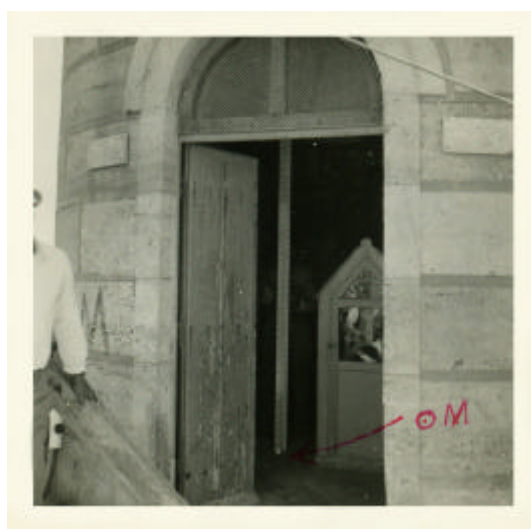
Fotografia do marégrafo indicando a marca de contacto do poço do marégrafo (1940) Esta marca define o Zero do marégrafo
